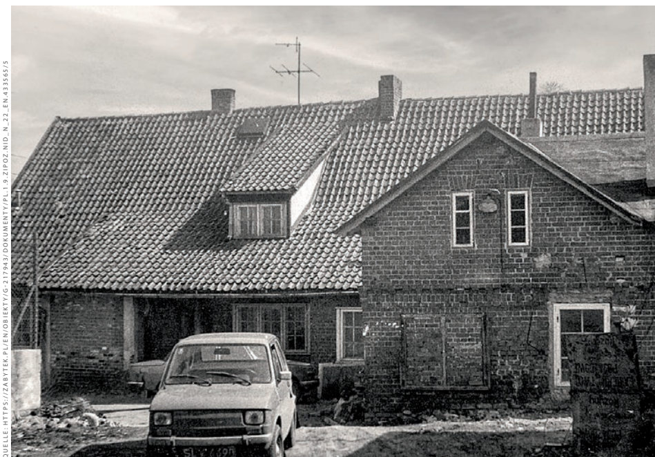
Blick auf die Westfassade: Ziegelsteinanbau aus dem Jahr 1906, auf einem Foto aus den 1980er Jahren
