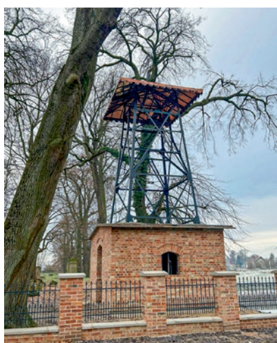
Blick auf den ehemaligen evangelischen Friedhof mit dem Stahlgerüst des Glockenturms
