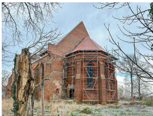
Das für Glaserarbeiten eingerüstete Presbyterium
