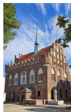
Das Alte Rathaus nach der ersten Renovierungsphase
