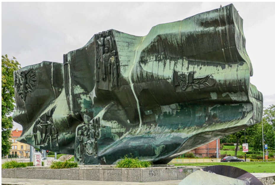
Der Zustand des Denkmals im Jahre 2016
