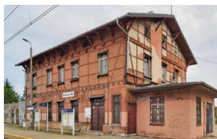
Das baufällige Bahnhofsgebäude von Gronowo Elbląskie
