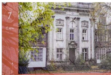
Der Zustand des Hauses vor der Renovierung
