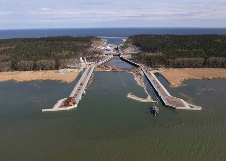
Der Kanal durch die Frische Nehrung – Ansicht von der Haff-Seite aus (Diese und die übrigen Aufnahmen stammen aus dem April 2022.)
