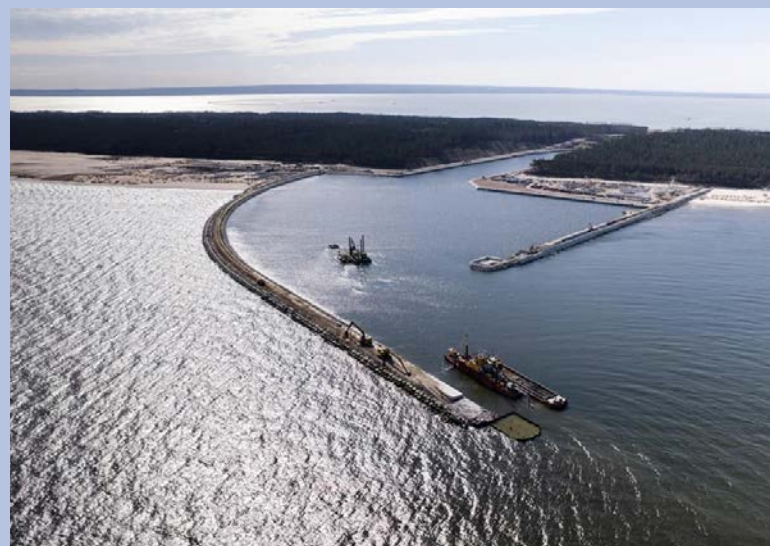
Ansicht von der Seite der Danziger Bucht aus. Im Vordergrund die im Bau befindlichen Molen mit dem kleinen Hafen und den Wartepätzen für einlaufende Schiffe
