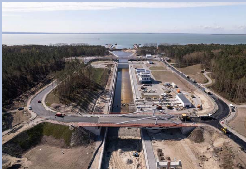
Das Zentrum des Kanals mit der Schleusenanlage und der Straßenführung über zwei Drehbrücken
