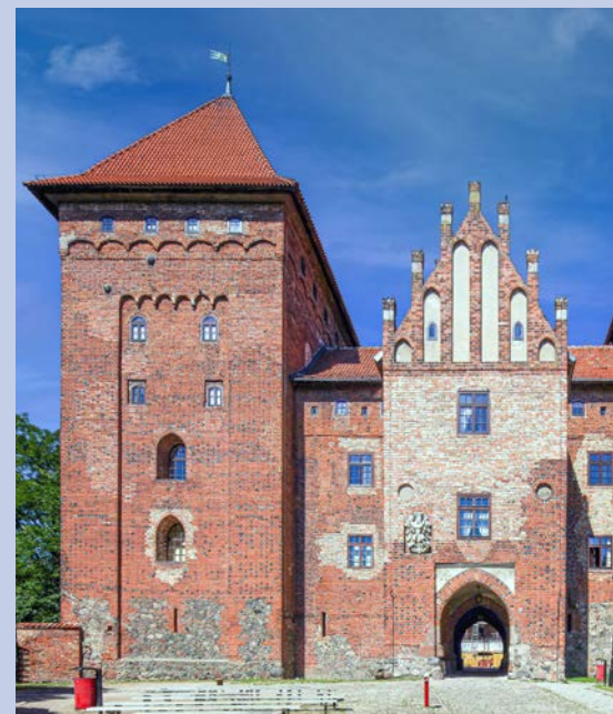
Doppelturmfassade der Burganlage Neidenburg
