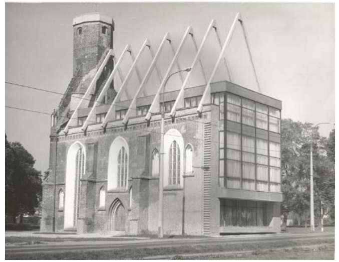
Der Umbau der Hl. Leichnam-Kirche zum Kulturzentrum nach Entwürfen des Architekten Andrzej Macur
