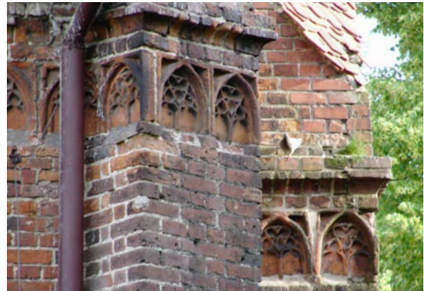
Fries unterhalb des Dachgesimses aus plastischen Formsteinen mit Maßwerk-Dekor
