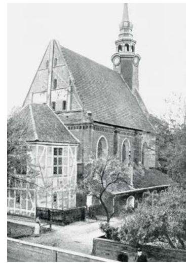
Der Zustand des Bauwerks vor 1895 mit dem Fachwerk-Chor und dem kleineren Anbau an der Südseite
