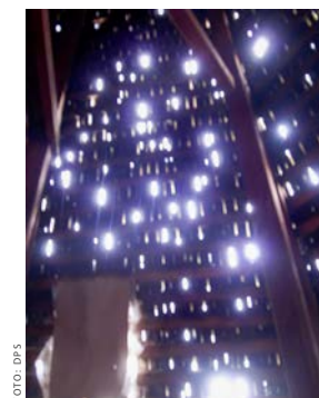
Undichte Holzschindeldeckung des Turms von innen, Februar 2013
