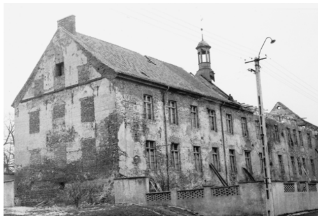
Gymnasiumsgebäude während der Sanierungsarbeiten von 1972, durch die das Gebäude an seine neue museale Verwendung angepasst wurde.
