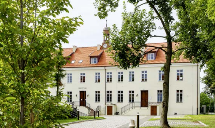
Das Gymnasiumsgebäude nach den Renovierungsarbeiten von 2018, Ansicht von der Hofseite
