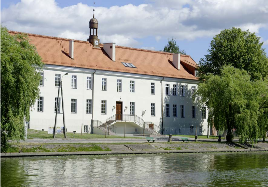
Gymnasiumsgebäude nach den Renovierungsarbeiten, westliche Ansicht
