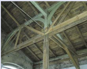
Der freie Blick in die Dachkonstruktion
