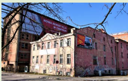
Der gegenwärtige Zustand der noch nicht renovierten Richter-Mühle
