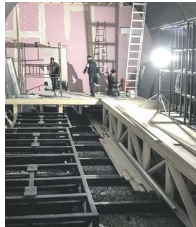
Zustand des Innenausbau (Mitte April)
