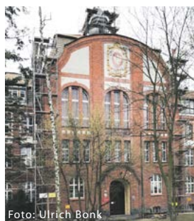
Renovierungsarbeiten am Gebäude der UTP in der ul. Seminaryjna 3.
