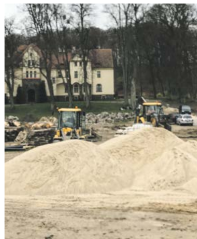
Schloss Below im Hintergrund der Baustelle
