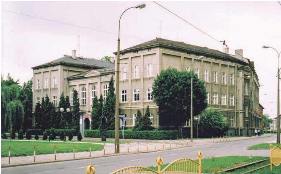
Die Schule vor der Renovierung (2007)
