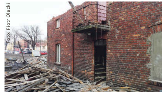
Abrisshaus an der Culmer Chaussee
